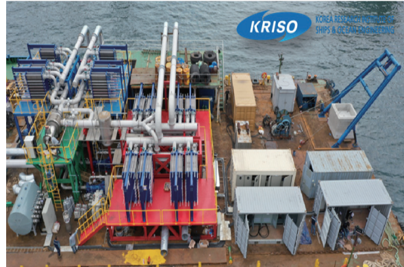
1MW 해수온도차발전플랜트 조립(부산항, '19)
